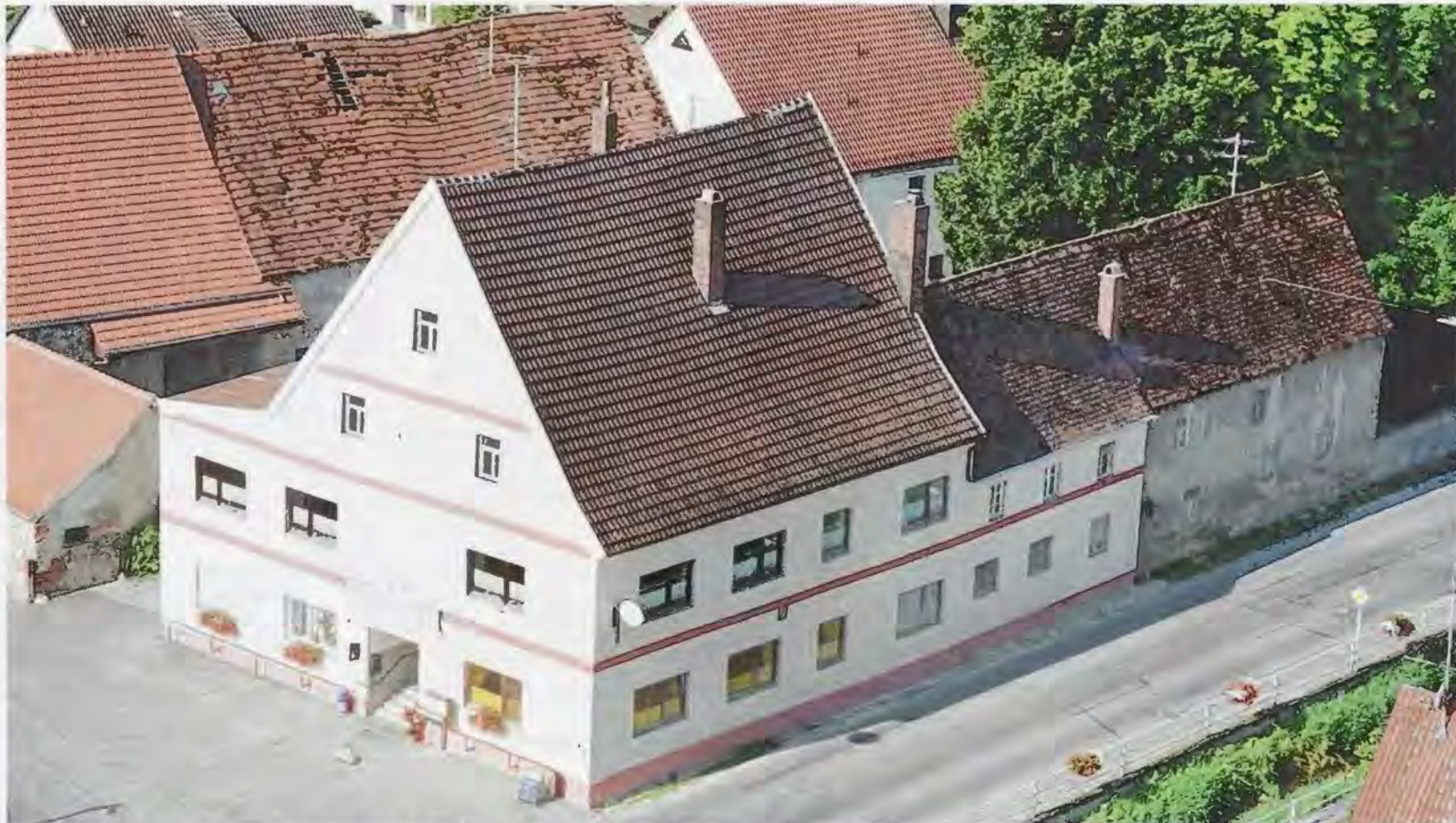
Das ehemalige Gasthaus Adler in Haunsheim hat eine lange Tradition. Hier ein Bild aus dem Jahr 2001, aufgenommen vom Kirchturmgerüst. Fotos: Haßler, Schopf (Archiv)
