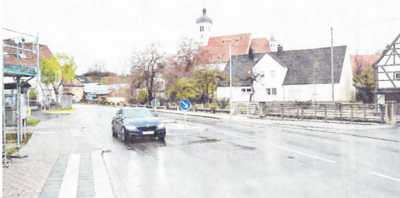
Bereits abgeschlossen: Die Ortsdurchfahrt in Haunsheim wurde saniert.
